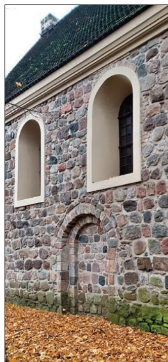
Ehemaliger Kircheneingang vor dem Umbau 1953.
